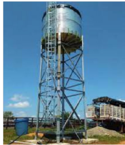
2 TANQUE DE DISTRIBUCIÓN Y ALMACENAMIENTO ELEVADO
